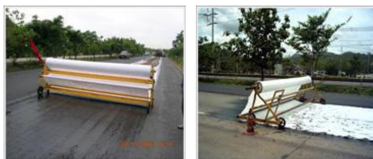
รูปที่ 2.9 การปูแผ่นใยสังเคราะห์
