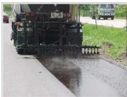
รูปที่ 2.8 การฉีดพ่นแอสฟัลต์
