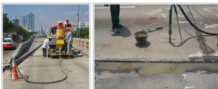
รูปที่ 2.5 การอัดน้ำปูน (Sub Sealing)
