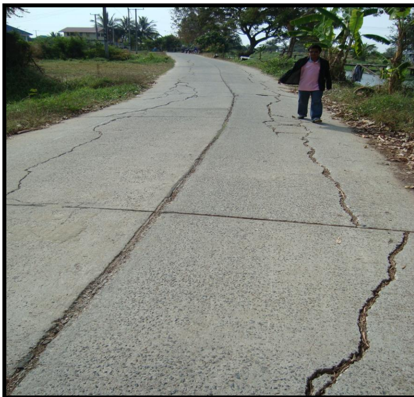
รูปที่ 4.7 ความเสียหายของถนน คสล. บ้านวังหิน หมู่ที่ 5 (เส้นที่ 4)
