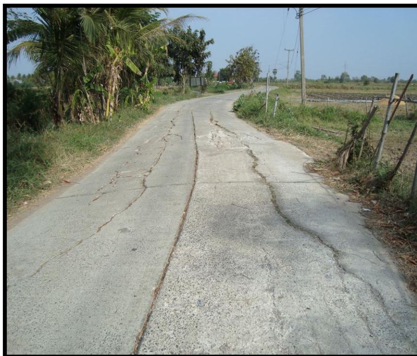
รูปที่ 4.5 ความเสียหายของถนน ค.ส.ล. บ้านวังหิน หมู่ที่ 5 (เส้นที่ 2)
