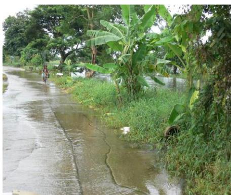
รูปที่ 2.11 ภาพความเสียหายของถนนคอนกรีตเสริมเหล็กที่ชำรุดเนื่องจากอุทกภัย ตำบลบ้านโพธิ์ อำเภอมือง จังหวัดนครราชสีมา
