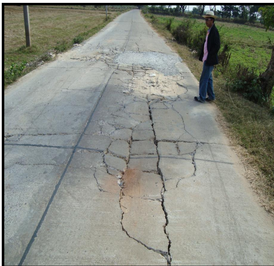
รูปที่ 4.4 ความเสียหายของถนน ค.ส.ล. บ้านวังหิน หมู่ที่ 5 (เส้นที่ 1)
