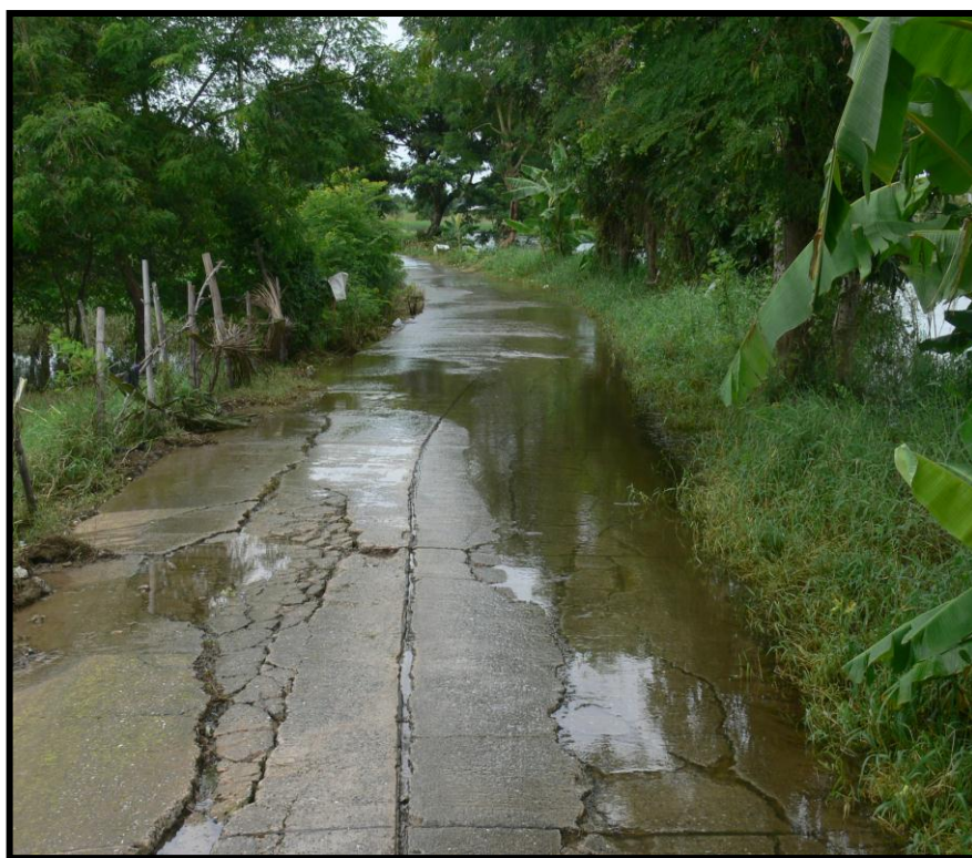
รูปที่ 4.1 ความเสียหายของถนน ค.ส.ล. บ้านยั้ง หมู่ที่ 1
