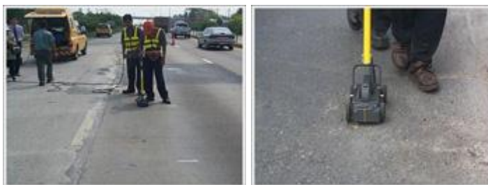
รูปที่ 2.3 การตรวจสอบโพรงใต้พื้นถนนคอนกรีต
