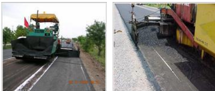
รูปที่ 2.10 การปูผิวจราจรใหม่
