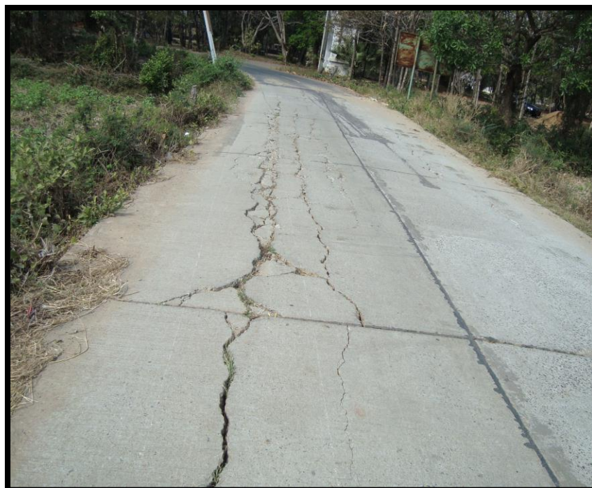
รูปที่ 4.6 ความเสียหายของถนน ค.ส.ถ. บ้านวังหิน หมู่ที่ 5 (เส้นที่ 3)
