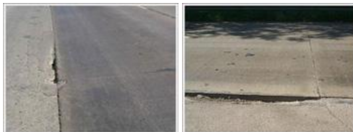
รูปที่ 2.2 ภาพแสดงโพรงขนาดใหญ่ที่รอยต่อระหว่างผิวถนนคอนกรีตกับไหล่ทางลาดยาง
