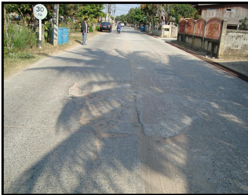
รูปที่ 4.8 ความเสียหายของถนน คสล. บ้านวังหิน หมู่ที่ 5 (เส้นที่ 5)
