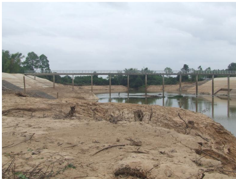
ภาพภาพผนวก ก-1 (ต่อ) สภาพพื้นที่ตั้งโครงการก่อสร้างฝายยางท่าทางเกวียน ณ วันที่ 30 มี.ค. 54
