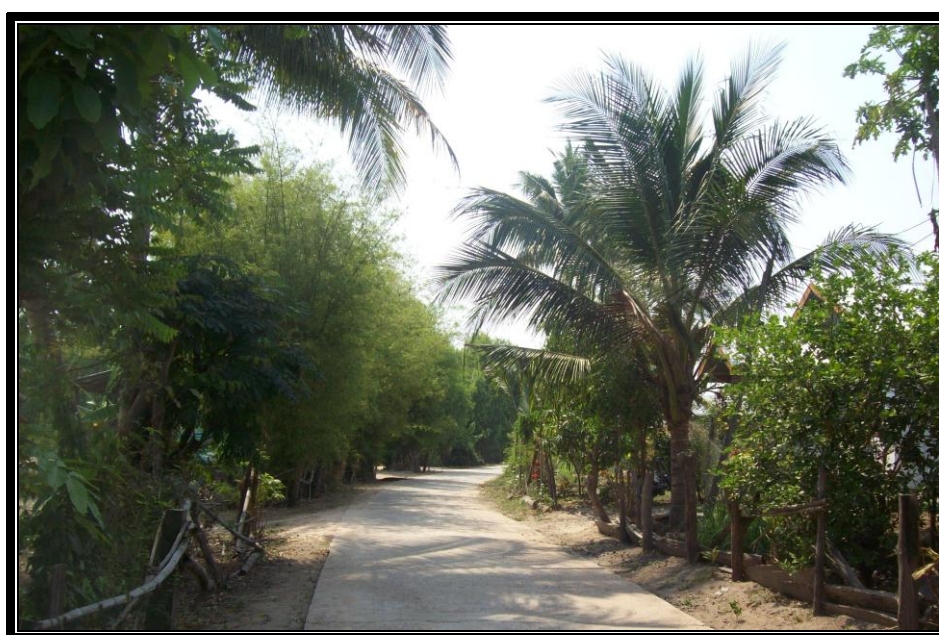
รูปที่ 4.4 ถนนลาดยางสายบ้านหัวฝาย - นาลาว หมายเลข 3005 ที่ จะทำการขยายเขตไฟฟ้าแรงต่ำ และติดตั้งโคมไฟฟ้าแสงสว่างสาธารณะ พร้อมสายอลูมิเนียม
