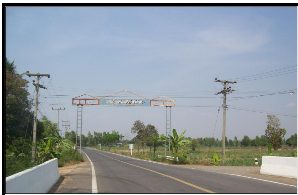
รูปที่ 4.3 ทางแยกจากถนนลาดยางสายบ้านหัวฝาย - นาลาว หมายเลข 3005 ที่จะทำการติดตั้ง โคมไฟฟ้าแสงสว่างสาธารณะ พร้อมสายอลูมิเนียม
