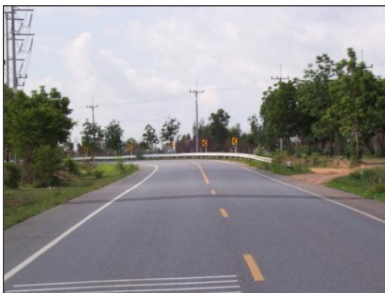
รูปที่ 3.3 ก่อนดำเนินการก่อสร้างบริเวณทางโค้ง PI STA. 5+288.850
