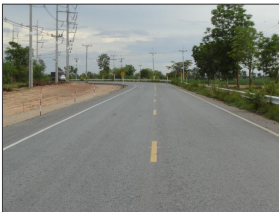
รูปที่ 3.4 ขณะดำเนินการก่อสร้าง บริเวณทางโค้ง PISTA. 5+288.850
