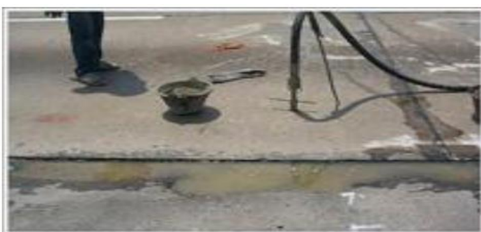
รูปที่ 4.16 การอัดน้ำปูน (Sub Sealing) ที่มา: คู่มือการซ่อมบำรุงทาง 2549 64-69น.
