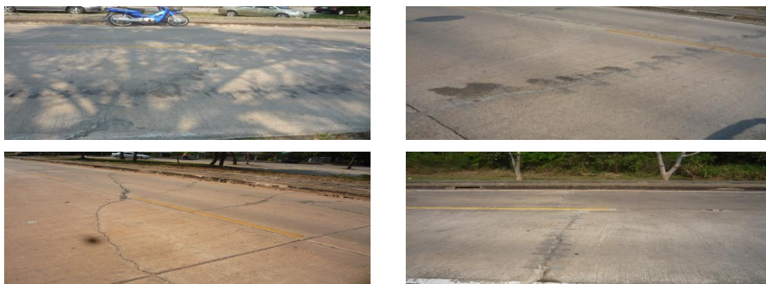
รูปที่ 3.2 ลักษณะความเสียหายที่มีการซ่อมแซมแล้วบางส่วน
