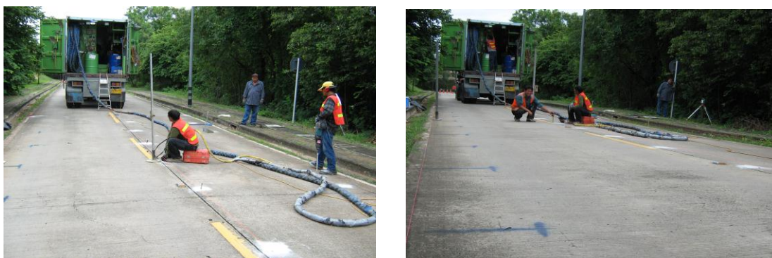
รูปที่ 4.19 การซ่อมแซมอุดโพรงแผ่นพื้นคอนกรีตผิวทางแบบฉีดสารโพลียูรีเทน เมื่อปี พ.ศ.2552
