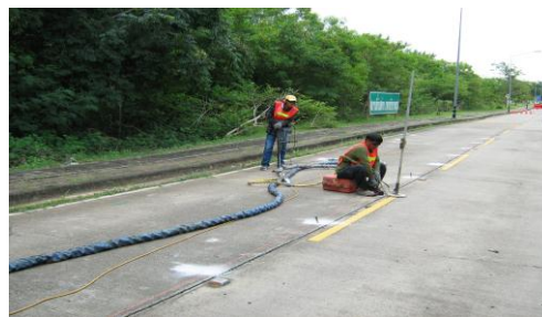
รูปที่ 2.8 การตรวจค่าระดับหลังฉีดสารยูรีเทค พ.ศ.2552
