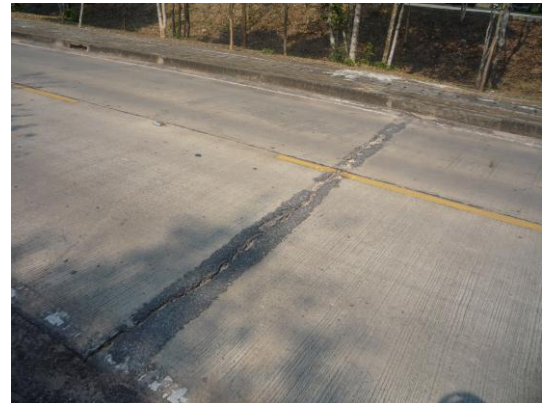
รูปที่ 4.11 การเลื่อน หรือยกตัวของรอยต่อตามขวางหรือรอยแตก
