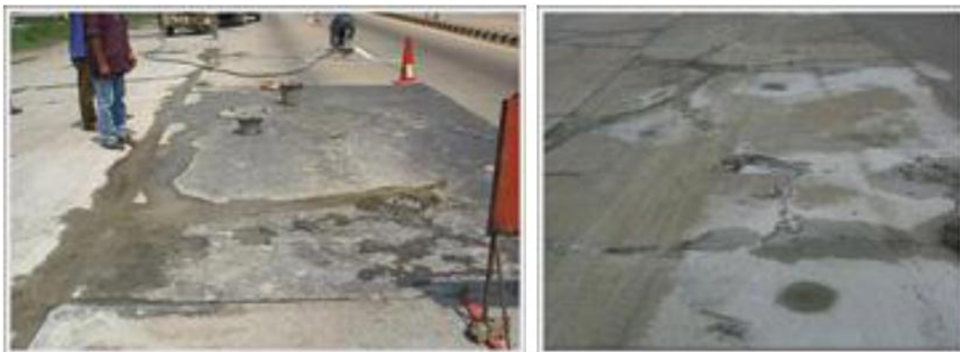
รูปที่ 2.7 การอัดน้ำปูนต่อไปจนเต็มโพรง (ที่มา: คู่มือซ่อมบำรุงทางหลวง (Road Maintenance Manual))
