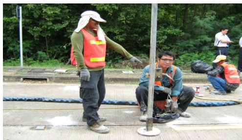
รูปที่ 2.8 การตรวจค่าระดับหลังฉีดสารยูรีเทค พ.ศ.2552
