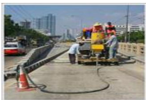
รูปที่ 4.16 การอัดน้ำปูน (Sub Sealing) ที่มา: คู่มือการซ่อมบำรุงทาง 2549 64-69น.
