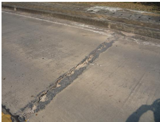
รูปที่ 4.11 การเลื่อน หรือยกตัวของรอยต่อตามขวางหรือรอยแตก
