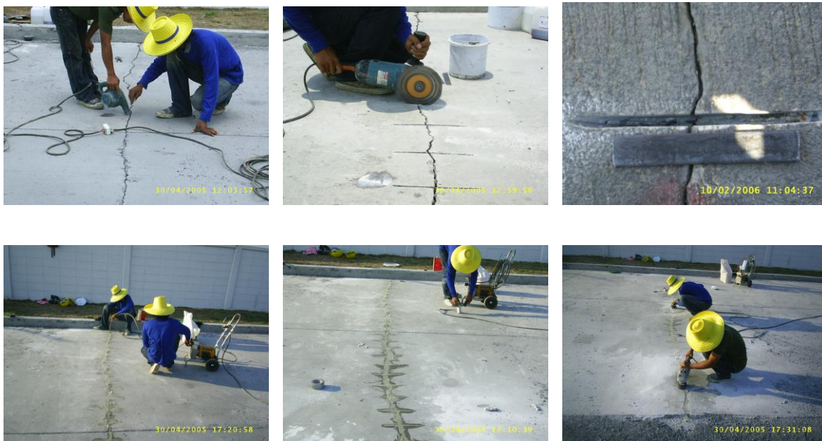
รูปที่ 4.17 ขั้นตอนการทำงานซ่อมรอยร้าวด้วย Epoxy Injection
