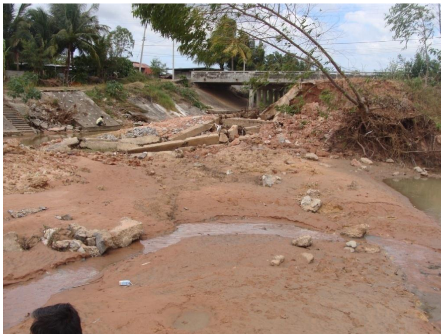
รูปที่ 2.18 ลักษณะการกัดเซาะตลิ่งจุดที่เป็นโค้งน้ำของคาคอนกรีตพร้อมเรียงหินใหญ่เดิม
