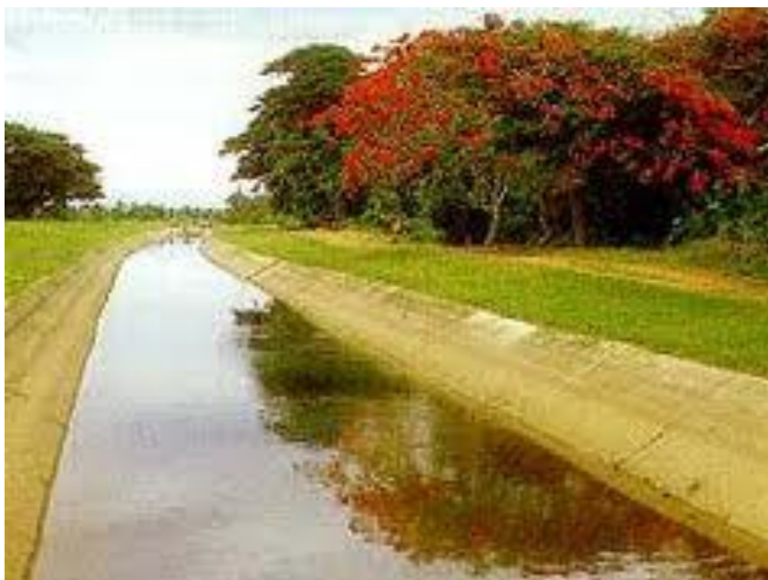
รูปที่ 2.13 คาคอนกรีตในคลองส่งน้ำ
