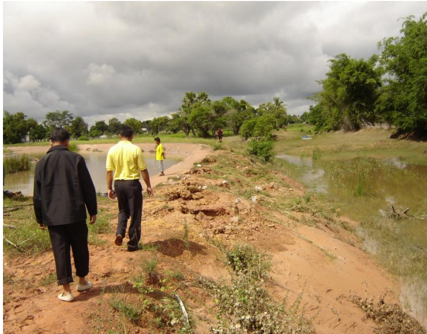
รูปที่ 2.17 ลักษณะการกัดเซาะตลิ่งจุดที่เป็นโค้งน้ำของคาคอนกรีตพร้อมเรียงหินใหญ่เดิม
