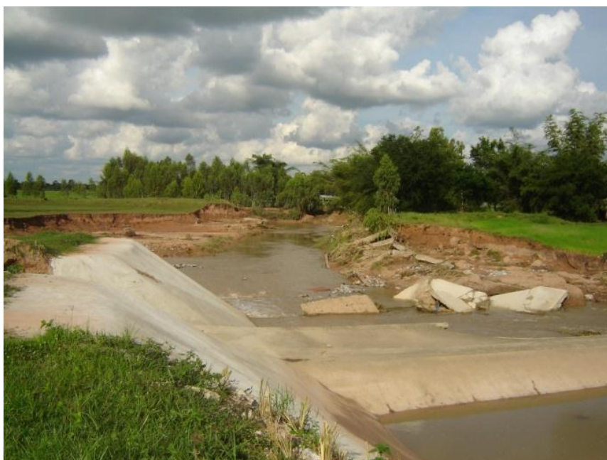
รูปที่ 2.15 ลักษณะการพังทลายของผนังและตลิ่งลำห้วยแคน(บริเวณ พิกัด N 1766250, E254250)
