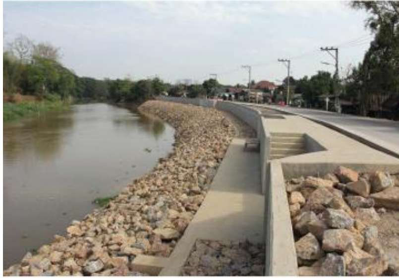
รูปที่ 2.10 ดาดคอนกรีตพร้อมเรียงหินใหญ่แม่น้ำชี
