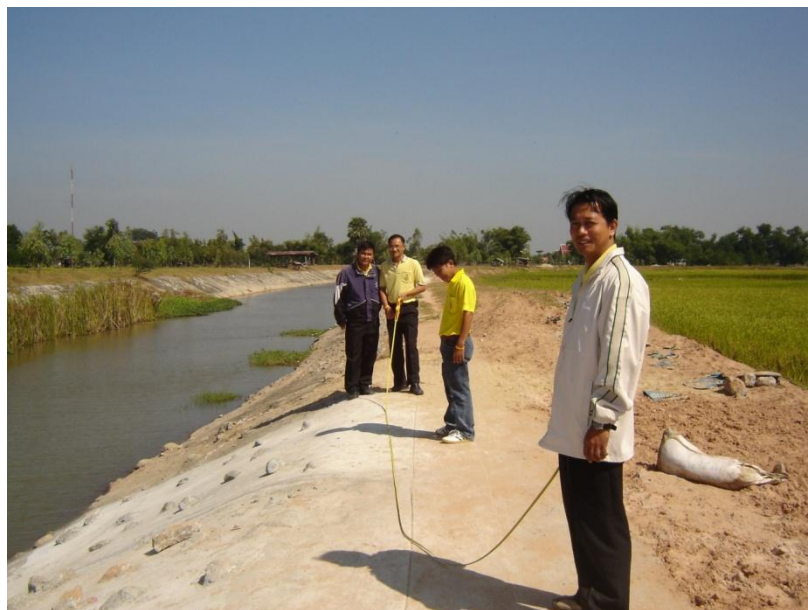
รูปที่ 2.11 ดาดคอนกรีตพร้อมเรียงหินใหญ่ลำน้ำชีสาขา
