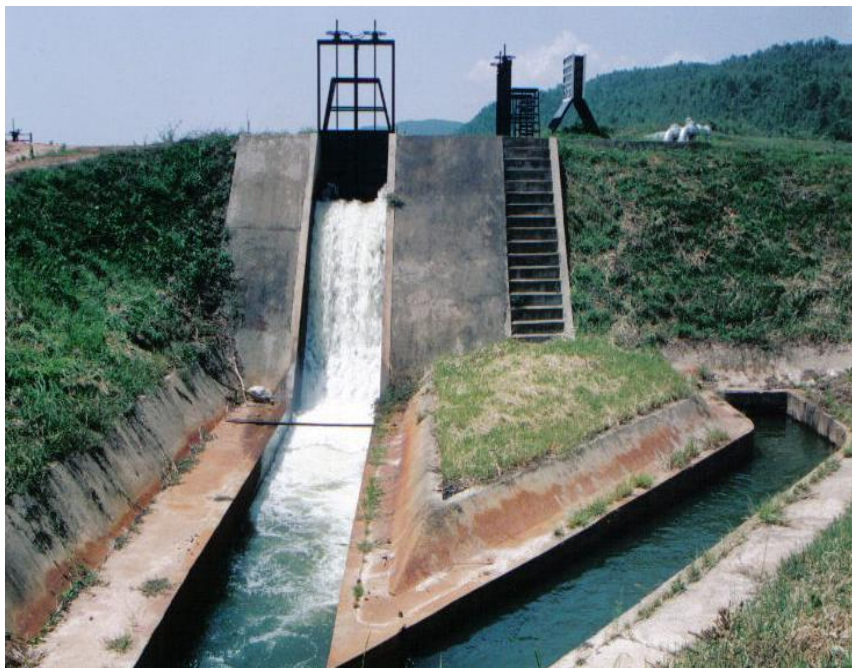
รูปที่ 2.14 คาดคอนกรีตในคลองส่งน้ำ
