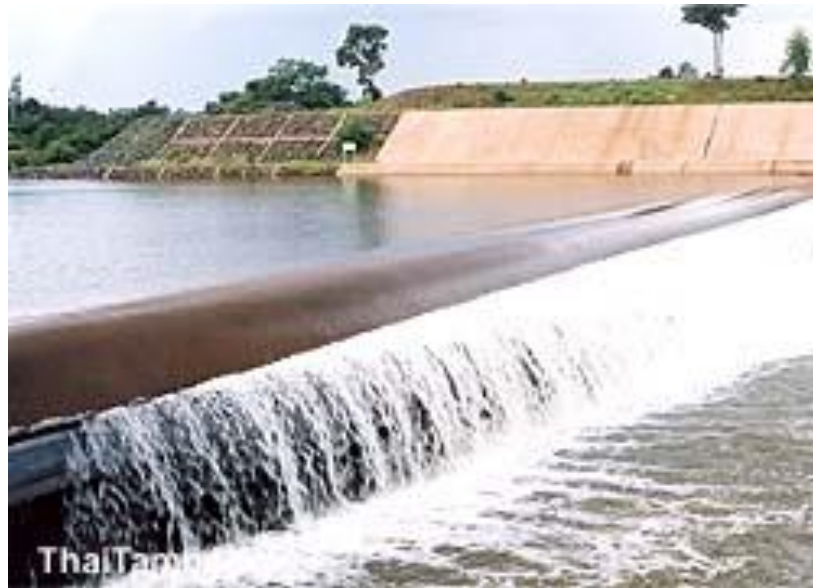
รูปที่ 2.8 คาดคอนกรีตพร้อมเรียงหินใหญ่ลำนน้ำมูลในเขต อำเภอสตึก
