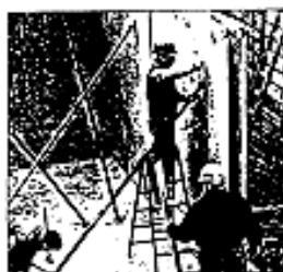
รูปที่ 2.12 การติดตั้งผนังกำแพงสำเร็จรูปผิวสองด้าน
