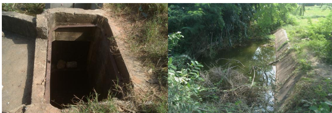
รูปที่ 3.11 บริเวณโครงการก่อสร้างรางระบายน้ำคอนกรีตเสริมเหล็กปัจจุบัน
